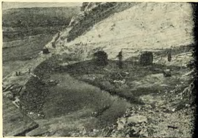
Vista de los trabajos en la Presa de "El Azúcar", Tamps. Esta Presa tendrá una capacidad de 2,100 millones de metros cúbicos.
