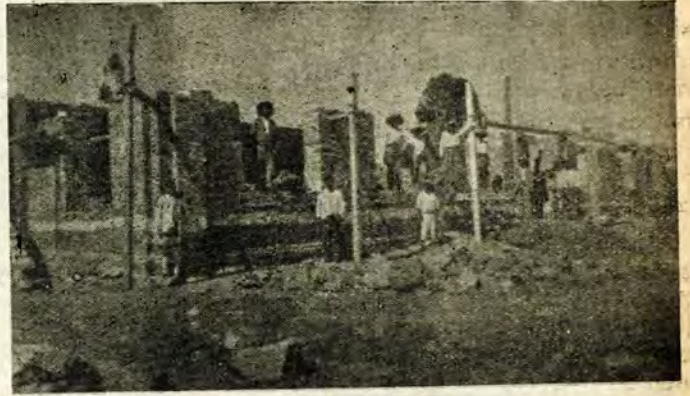
Escuela en construcción en San Francisco Calixtlauca. Al terminarse, tendrá cupo para 250.
